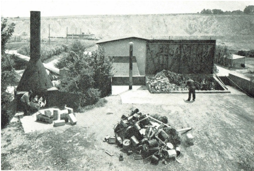
Abb. 1 Müllbunker für die Kompostieranlage im Blaubeurer Steinbruch. Sperrmüll wird aussortiert und verbrannt. Die Asche geht in den Kompost.
